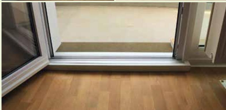
Um den Höhenunterschied zwischen Zimmer und Balkon deutlich zu reduzieren, ist der Einbau eines neuen Balkontür-Fensterrahmens erforderlich. Durch den Austausch des Fensterrahmens wird die Höhe der Schwelle, die beim Betreten des Balkons überwunden werden muss, deutlich kleiner. Auf der Balkonseite überbrückt zudem eine fest verbaute Rampe den verbliebenen Höhenunterschied zwischen Rahmen und Boden. Das sorgt für einen stabilen Auftritt.
