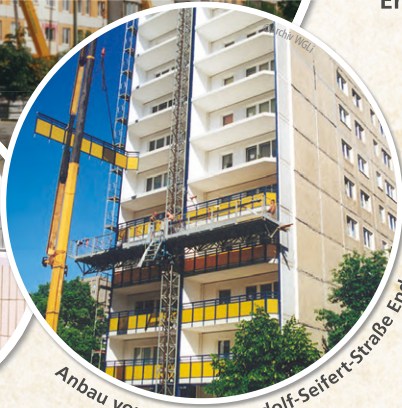
Einbau neuer Fenster
